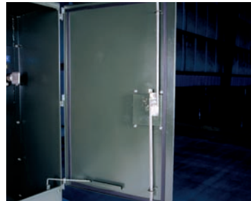
Mecanismo de enganche en 3 puntos
